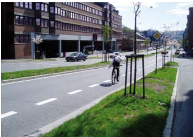
Tydelig markert sykkelfelt på Tøyen i Oslo. Sykkeltrafikken helt adskilt fra motorisert trafikk. Foto: Statens vegvesen, Eivind Kvambe
