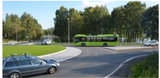
Ferdigstilt rundkjøring i Krokstadelva
