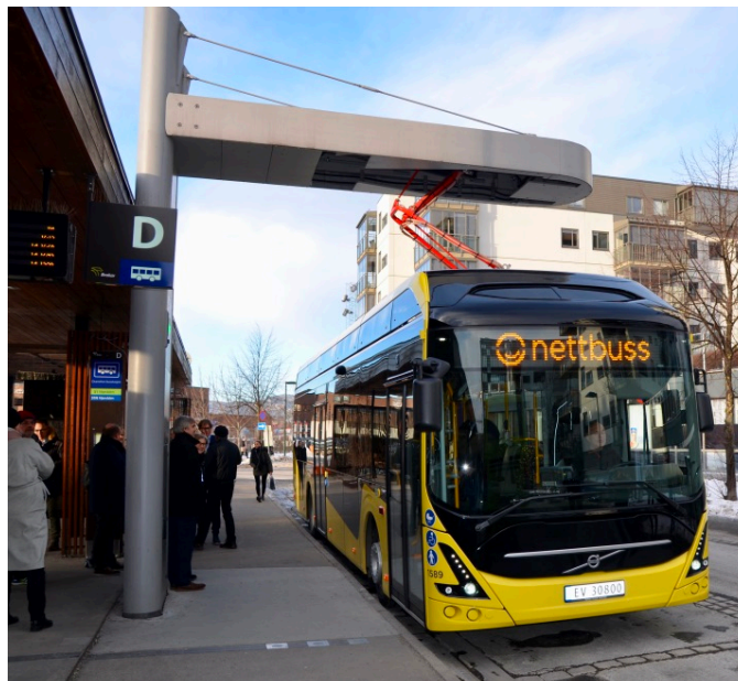
FERDIG: Ny hurtiglادestasjon for elbuss etablert på Drammen busstasjon.
