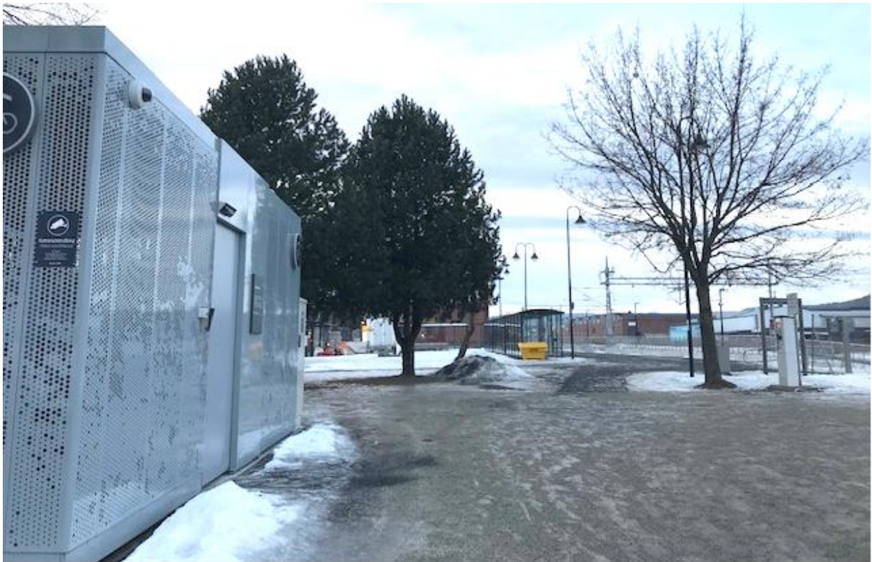
Nytt sykkelhotell ved Mjøndalen stasjon ble satt i drift i 2021.
