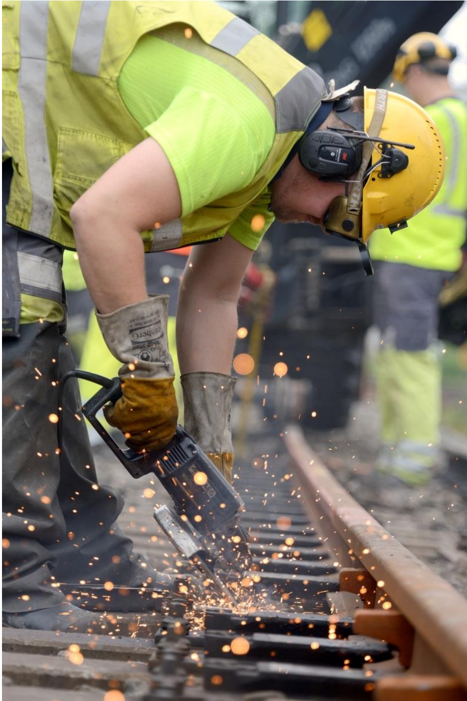
Bilde 1. Vedlikehold av sporveksel (Foto: Jernbaneverket)
