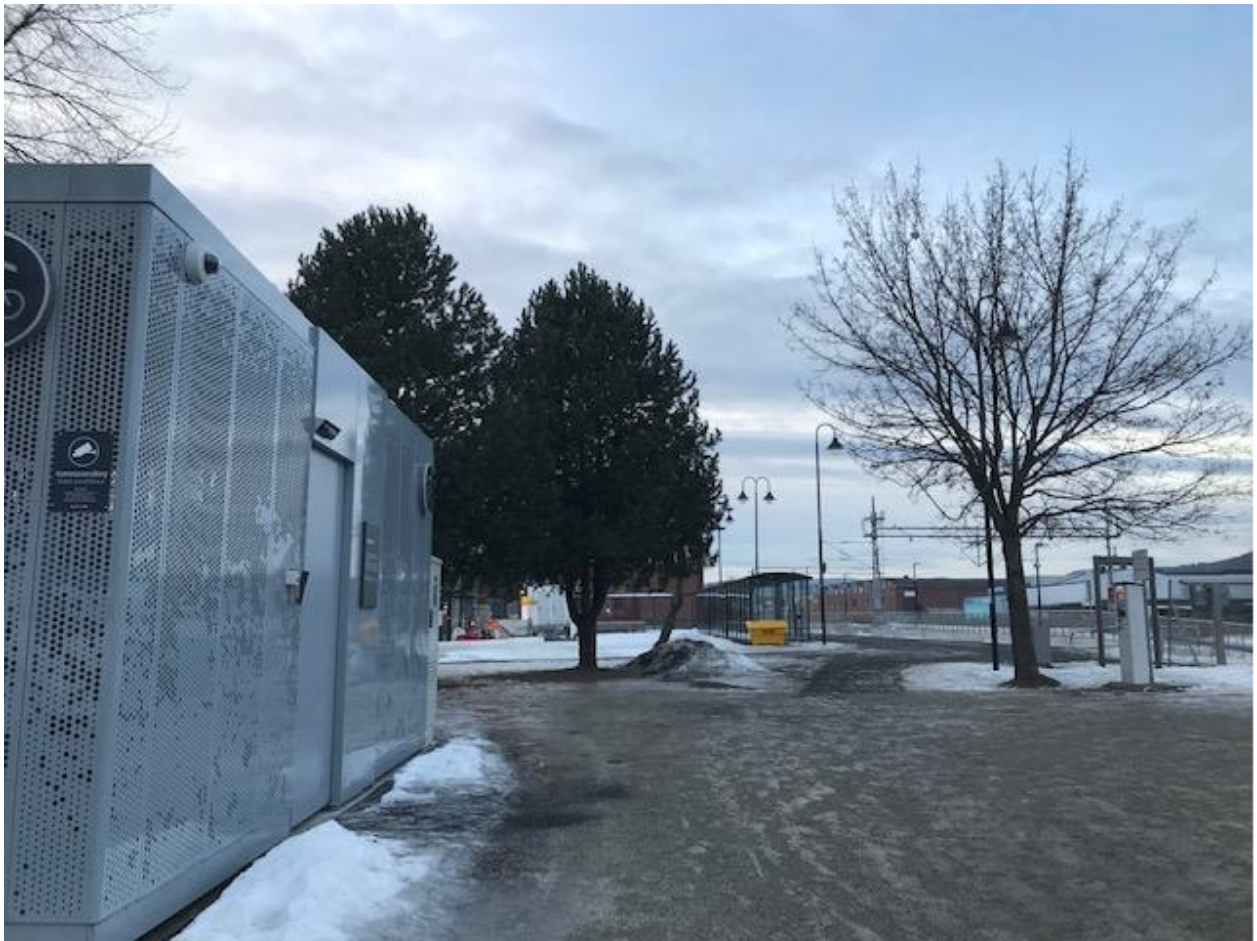
Nytt sykkelhotell ved Mjøndalen stasjon ble satt i drift i 2021.
