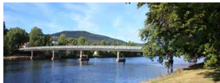
Landfalløybrua er sentral kobling mellom sykkelrutene på nord- og sørsiden av Drammenselva.
