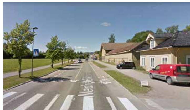
Bildet viser fv. 28 mellom Sundhauggata og Gulskogen, som i dag har sykkelfelt. Hva som blir framtidig standard på strekningen besluttes i pågående planarbeid.
