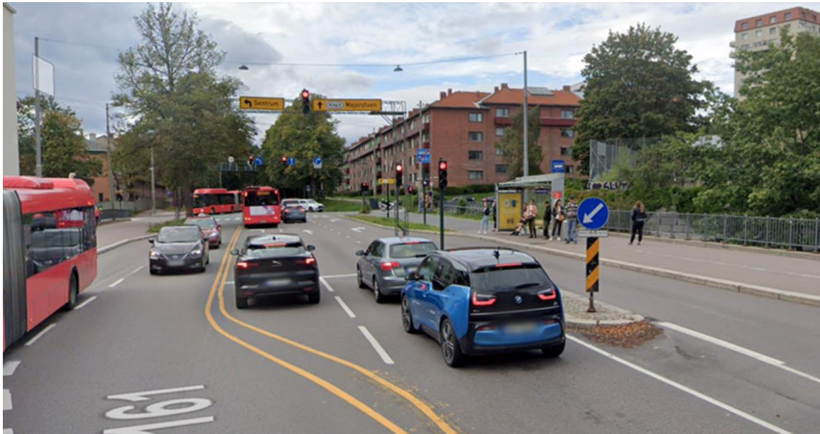
Figur 2 Signalanlegg med ASP og «gating» på Ring 2 i østgående retning før krysset med Fagerheimsgata i Oslo. Første lyskryss holder igjen biltrafikken til bussen har kommet fremst i køen, før ordinær biltrafikk slipper til. Foto: Google.
