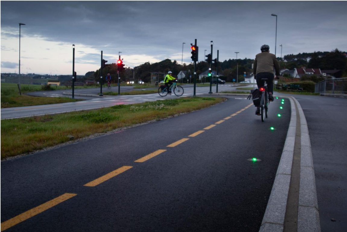
Et varmedetekterende kamera er montert på en stolpe i god avstand til lyskrysset og gir grønne indikasjonslys i asfalten - «grønn hale» - og grønt lys i krysset for syklisten. Foto: Alf Bergin
