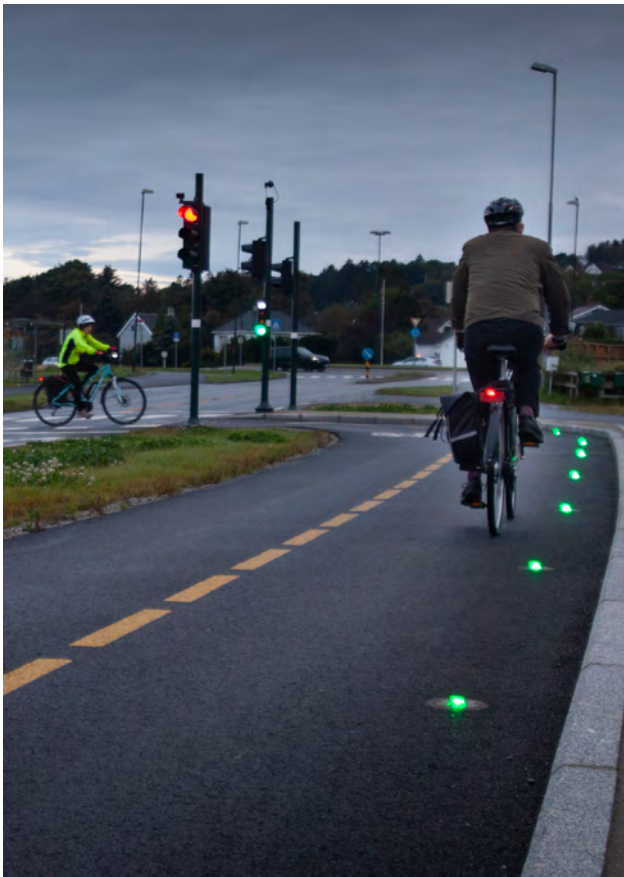
Indikasjonslys i asfalten - «grønn hale» - viser at syklistene får grønt lys i krysset. Foto: Alf Bergin.
