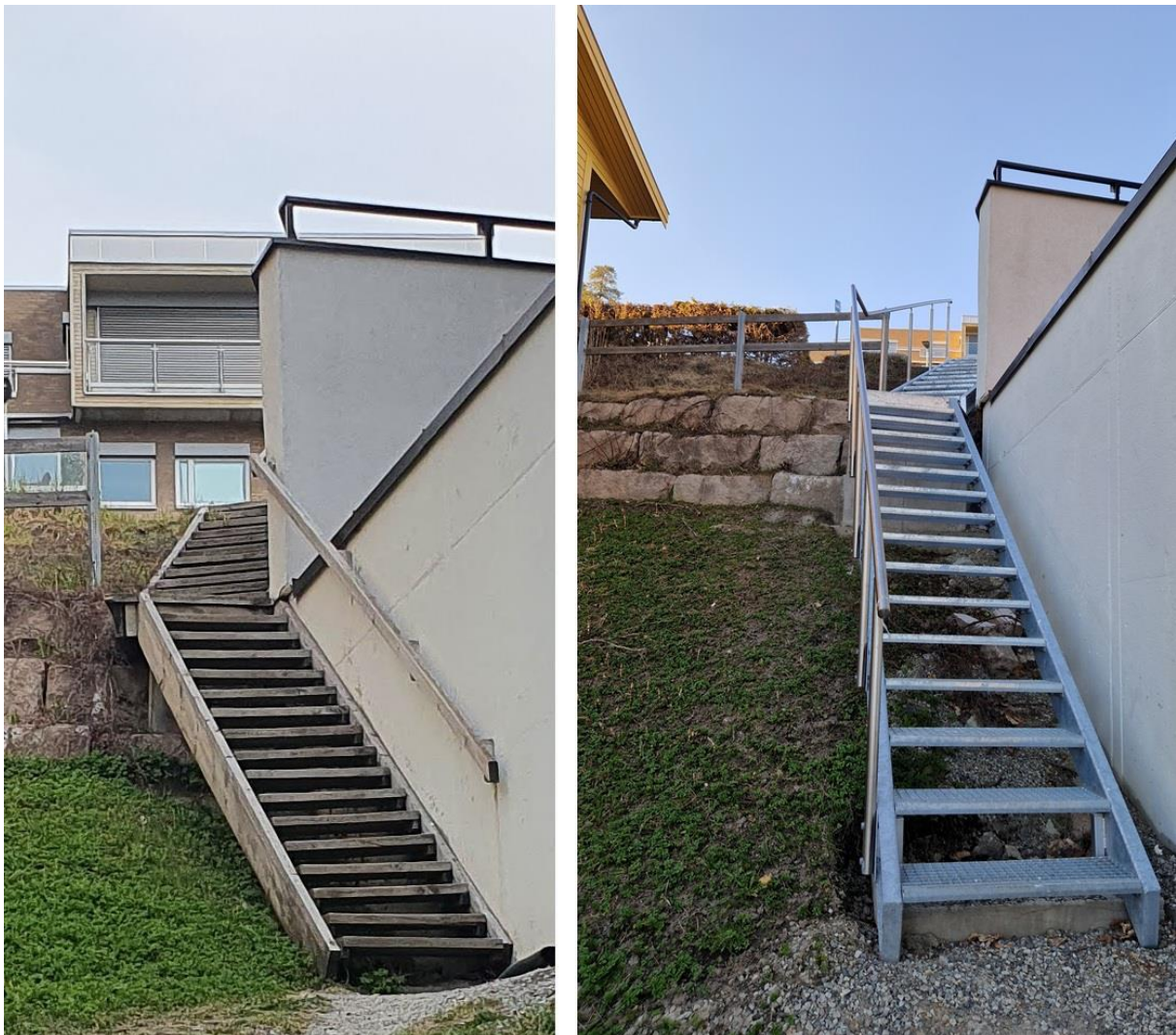
Figur 8 Gode snarveier kan bidra til at flere går og sykler. Flere av kommunene har brukt belønningsmidler på slike tiltak. Før- og etterbilder fra ny og sikrere trapp med godkjent rekkverk, og som er enklere å vinterdrifte, installert mellom Sanatorieveien og Rebbansbakken i Drammen. Foto: Drammen kommune og Buskerudbyen
