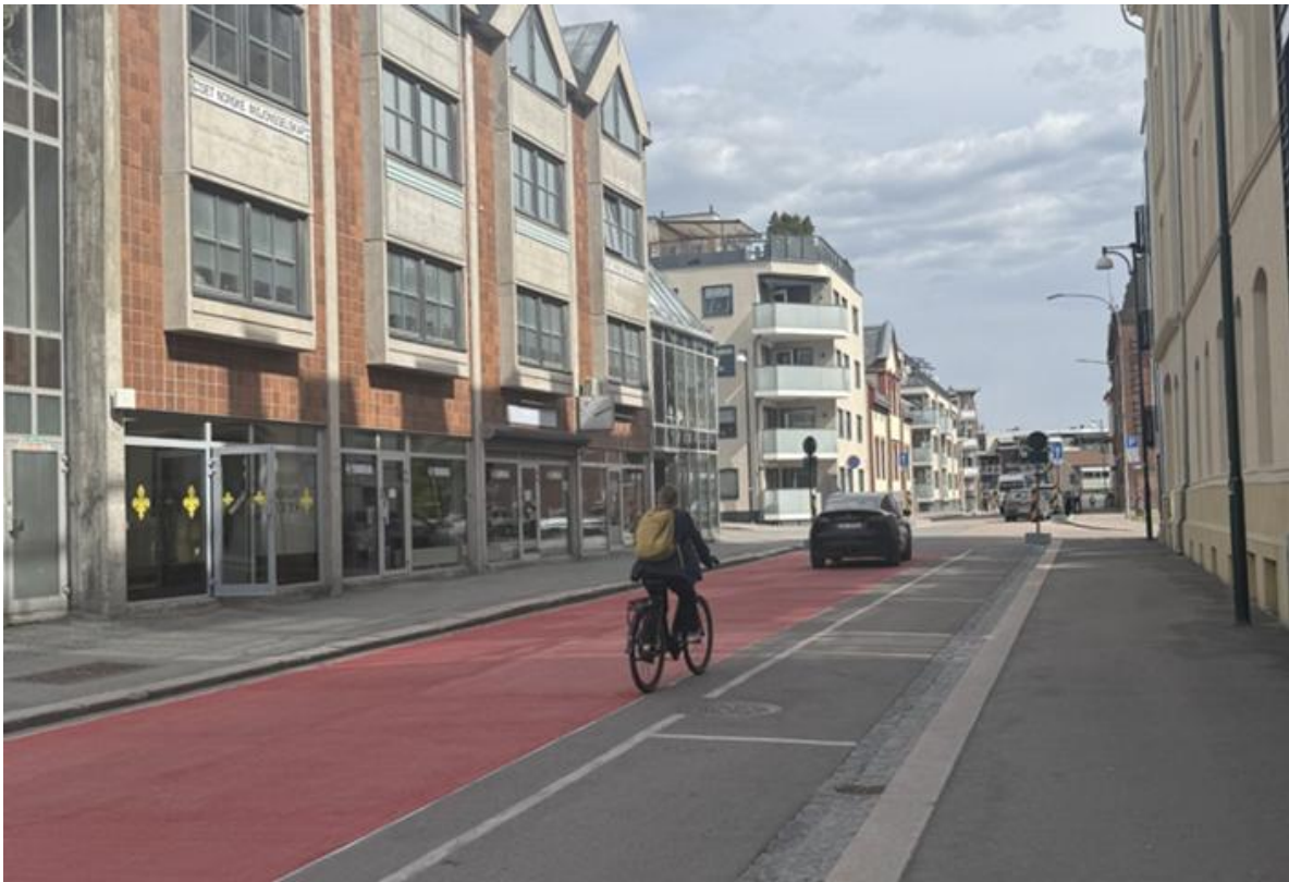
Sykkelprioritert gate i Nedre Storgate i Drammen – blant byens første. Foto: Drammen kommune
