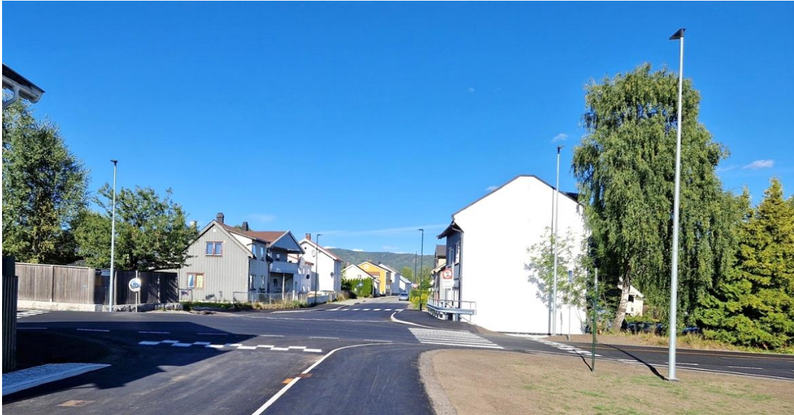
Figur 7 Oppgradering av kryss i Lier (Bruusgaardsvei, Lierstranda) som gagnar gående, syklende og kollektivreisende. Krysset er bygget om for å tilrettelegge for leddbusser til og fra det nye sykehuset, samtidig med at trafiksikkerheten er bedret, spesielt for gående.
