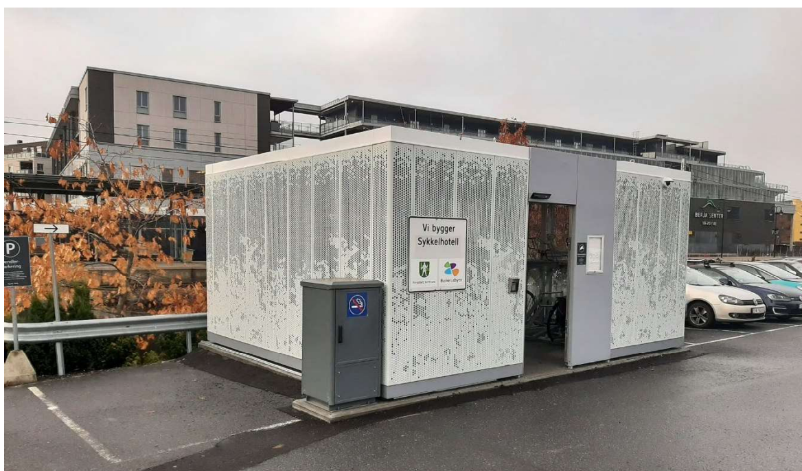
Figur 3 Nytt sykkelhotell på Kongsberg stasjon ble satt i drift sent i 2022. Innkjøpt, prosjektert og planlagt av kommunen, satt opp i samarbeid med Bane NOR Eiendom. Kostnadene er dekket av kommunen og belønningsmidler.
