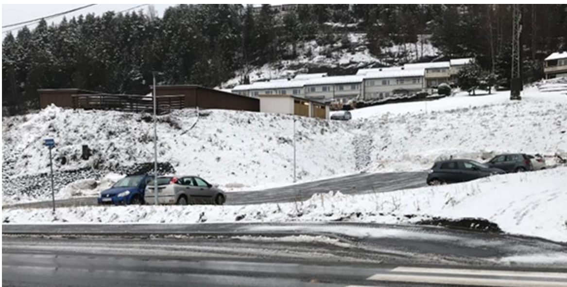
Ferdig høsten 2019: Ny innfartsparkering ved fv. 283 ved Nedre Eiker kirke.
